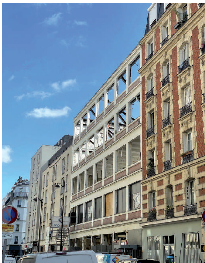
Le chantier : façade sur rue.
