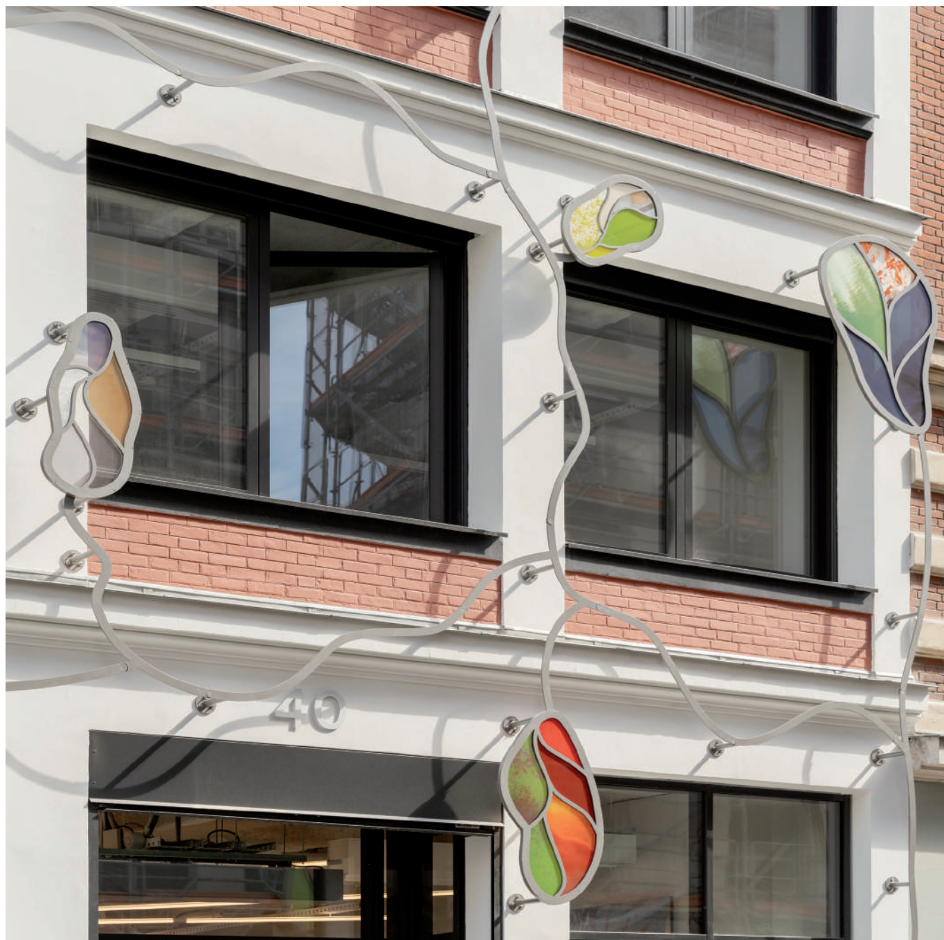
Une ossature en acier thermolaqué est fixée sur la façade.
