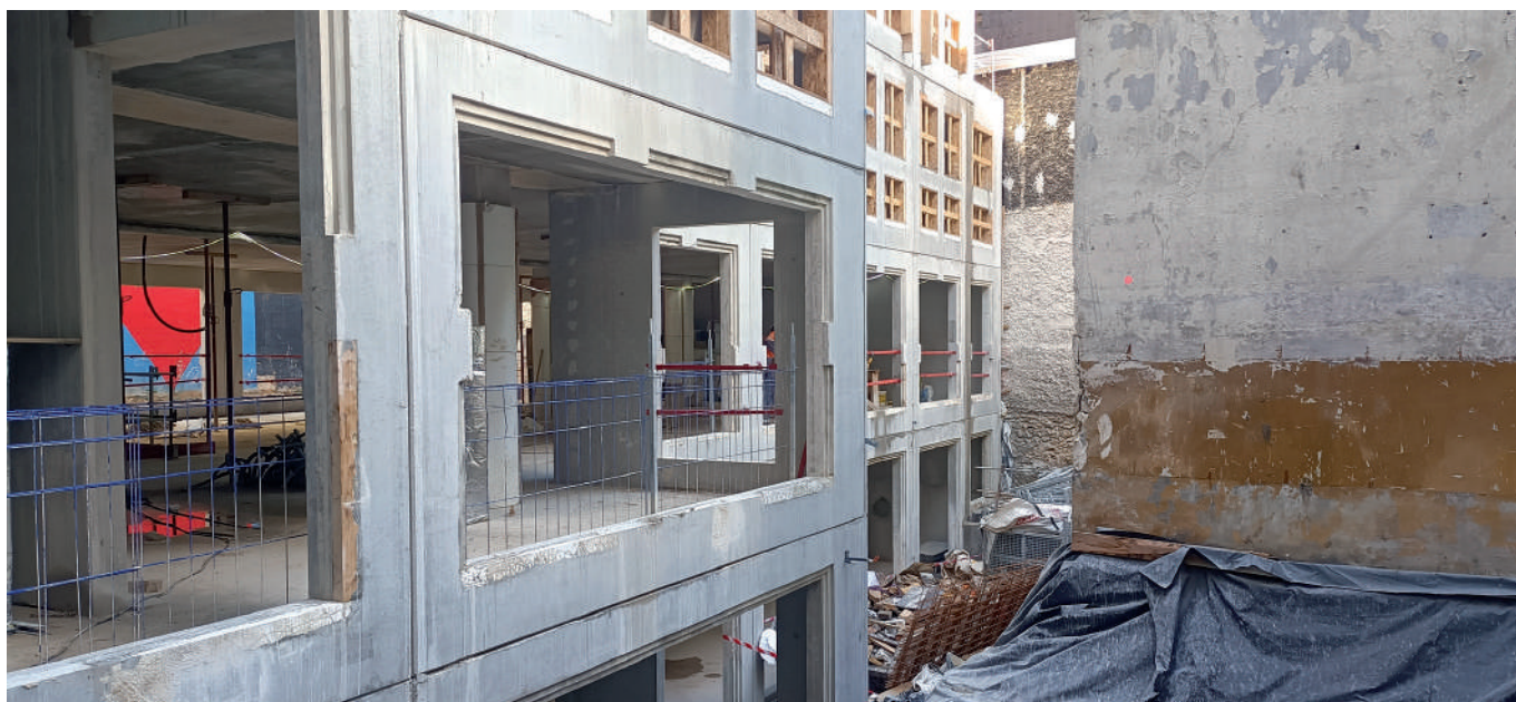
Le chantier, façade sur cour.
