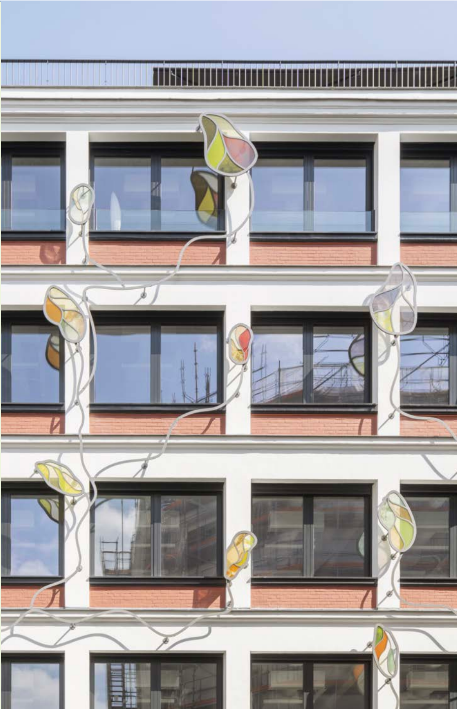
Façade de l'Institut français avec l'œuvre Hedera de Clara Rivault © Schnepf Renou
