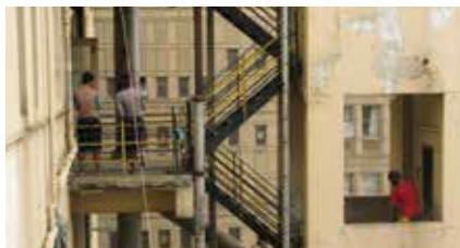
Chantier de la maternité abandonnée de Florence House ; Johannesburg, Afrique du Sud – 2011 © Christophe Hutin
