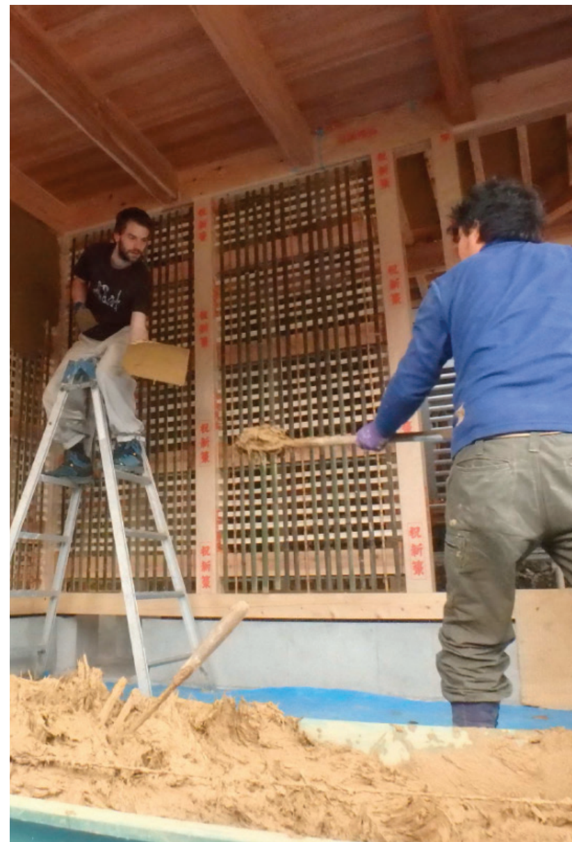
Johan Després - Chantier au Japon, 2016 © DR
